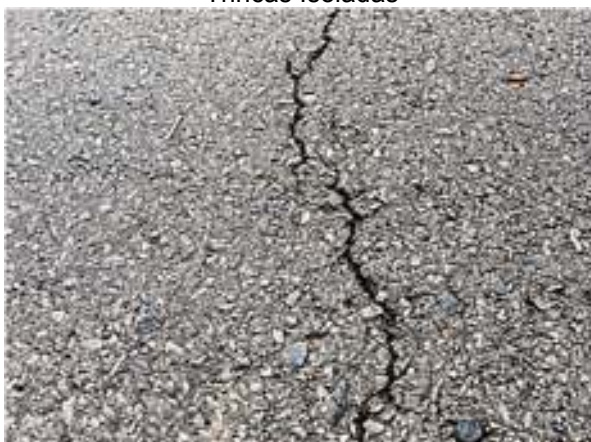
Trincas Isoladas
