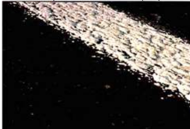
Sinalização Horizontal – Falha de Aplicação
