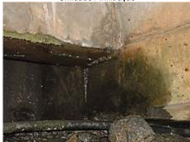
Umidade / Infiltração
