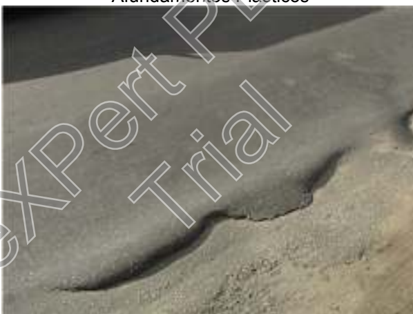
Afundamentos Plásticos
