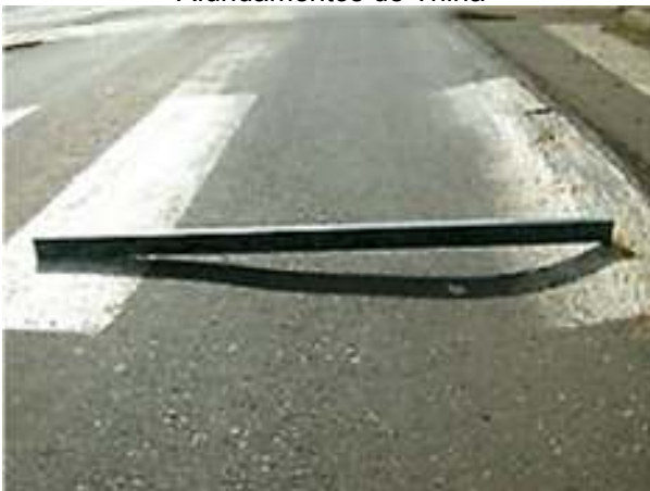
Afundamentos de Trilha
