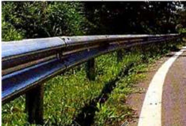
Defensa Metálica – Superfície e Fixações
