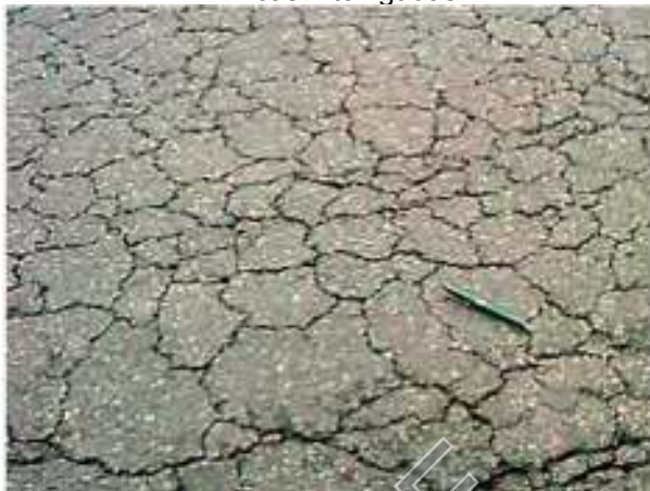
Trincas Interligadas
