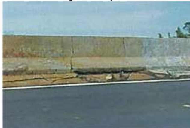
Barreira Rígida – Condições Estruturais
