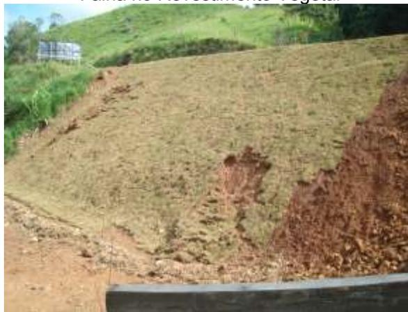
**Ausência de dissipador e Reaterro Lateral**
