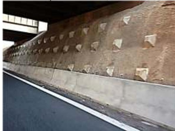
Cortina Atirantada - Manchas, Umidade, Trincas
